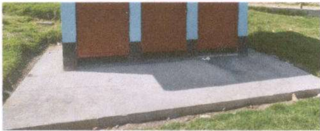
Foto 15: FUNDICION DE PISO FRENTE A SANITARIOS
