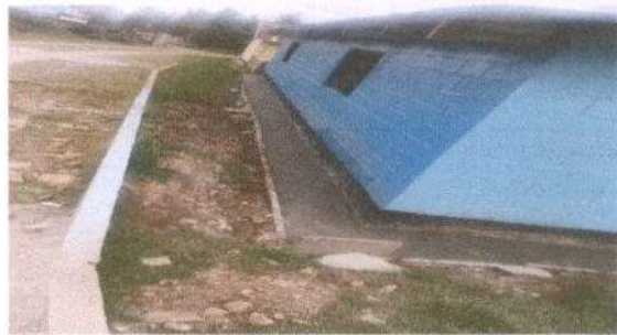
Foto 16: FUNDICION DE BANQUETA
