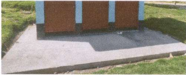
Foto 15: FUNDICION DE PISO FRENTE A SANITARIOS
