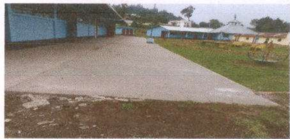
Foto 14: FUNDICION DE PISO
