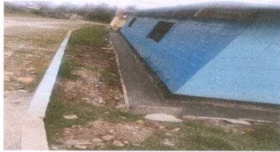
Foto 16: FUNDICION DE BANQUETA
