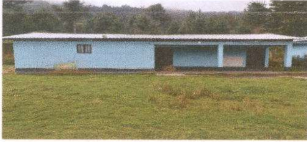
Foto 1: SUSTITUCION DE LAMINA, POR LAMINA TROQUELADA ALUZINC CALIBRE 26
