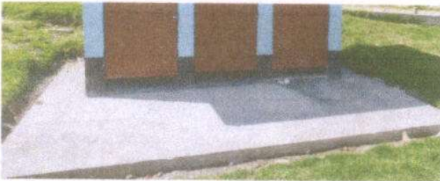
Foto 15: FUNDICION DE PISO FRENTE A SANITARIOS
