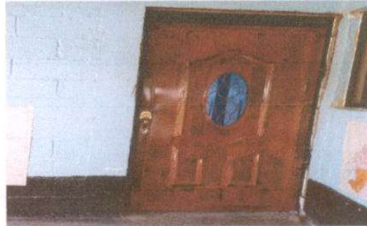
Foto 2: SUSTITUCION DE PUERTA DE MADERA POR METAL
