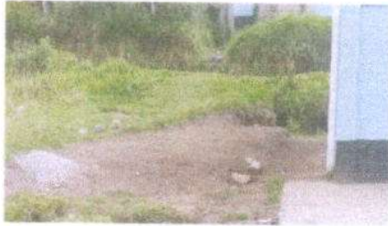
Foto 7: SUSTITUCION DE TUBERIA PVC LINEA PRINCIPAL AGUAS NEGRAS 3"
