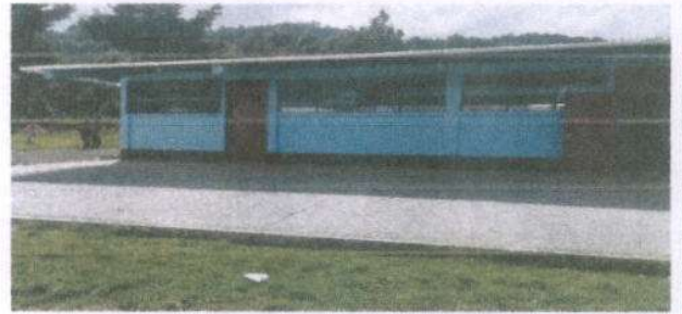
Foto 4: SUSTITUCION DE CANAL PVC
