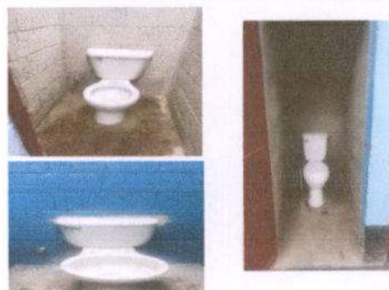
Foto 6: SUSTITUCION DE INODORO
