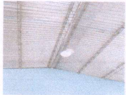
Foto 10: REPARACION DE LAMPARAS LED (INCLUYE CABLEADO)
