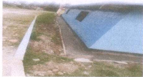
Foto 16: FUNDICION DE BANQUETA
