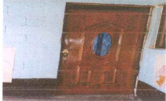
Foto 2: SUSTITUCION DE PUERTA DE MADERA POR METAL
