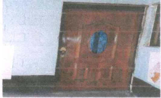
Foto 2: SUSTITUCION DE PUERTA DE MADERA POR METAL
