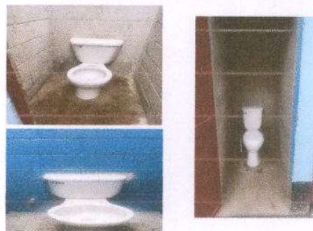
Foto 6: SUSTITUCION DE INODORO
