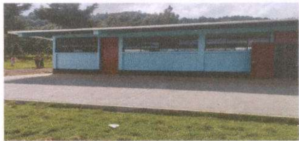
Foto 4: SUSTITUCION DE CANAL PVC
