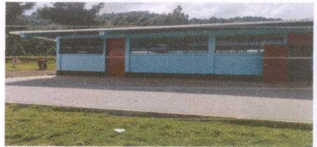
Foto 4: SUSTITUCION DE CANAL PVC
