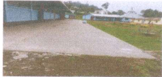
Foto 14: FUNDICION DE PISO
